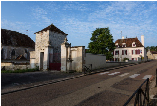
Le mur de la mairie
